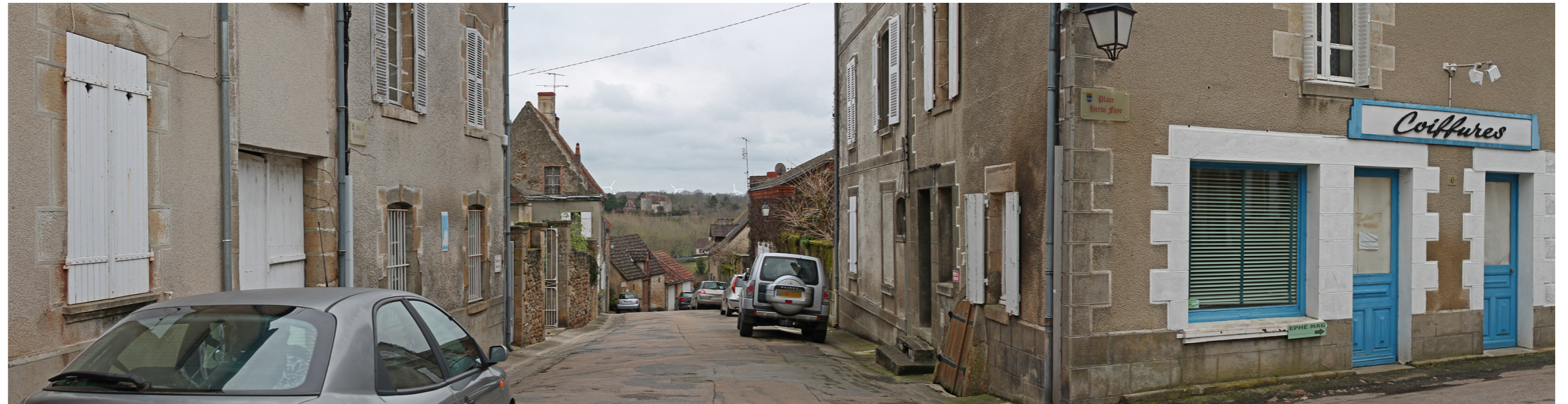
PDV F - Variante 1 : Plusieurs rues descendent vers la vallée du Portefeuille dans la cité médiévale de Saint-Benoît-du-Sault. Des percées visuelles vers l'environnement sont possibles dans la partie sommitale de ces rues. On constate une co-visibilité avec le château Montgaraud depuis la rue Beauregard. Les pales dépassent les massifs boisés et constituent un point d'appel concurrentiel au patrimoine protégé.
